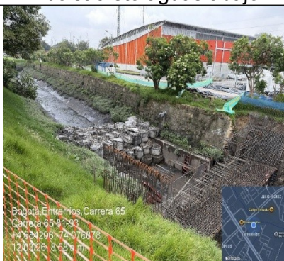
Fotografía No. 5. Vista superior Estructura de control y bolsacreto aguas arriba.
