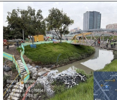
Fotografía No. 4. Vista superior bolsacreto aguas abajo y flujo de cauce canal río Nuevo.
