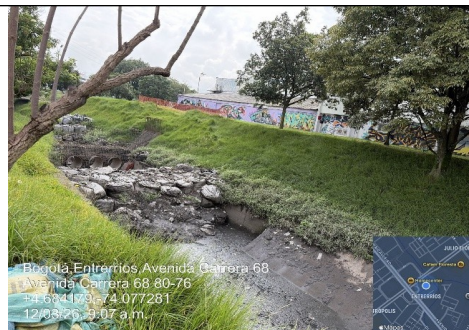
Fotografía No. 10. Vista posterior estructura de control y bolsacreto aguas arriba.
